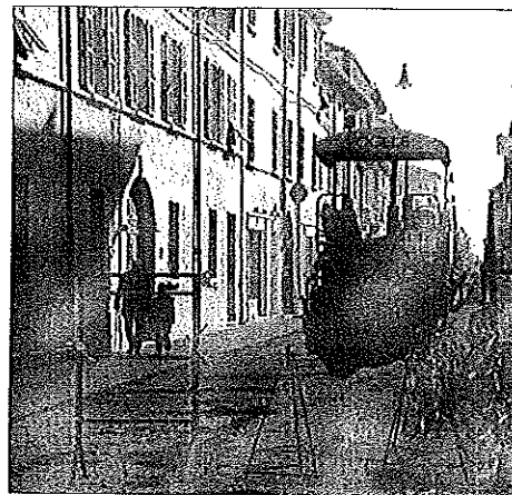
Il cantiere aperto in via Garibaldi
