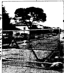
La zona dei lavori di via Bonoli
