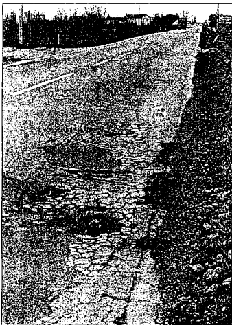
Asfalto nuovo per le strade con le buche
