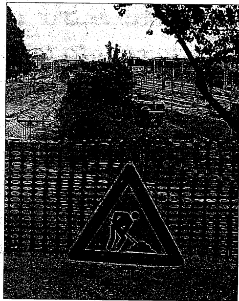
Lavori in corso: quest'anno alla viabilità e all'edilizia scolastica bassoromagnola spetteranno pochi spiccioli, ma tutti. saranno spesi in chiave sicurezza
