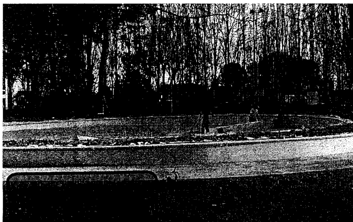
CANTIERE Operai al lavoro nella grande fontana all'ingresso del parco del 'Tondo'
