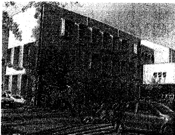
LAVORI La sede del Compagnoni. Il blocco di palestra e spogliatoi sarà bonificato entro maggio
