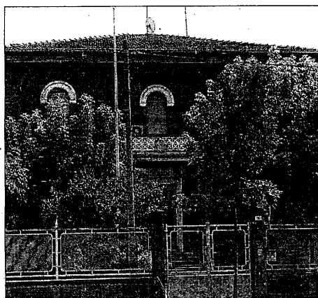
L'attuale caserma dei vigili del fuoco in via Mentana
