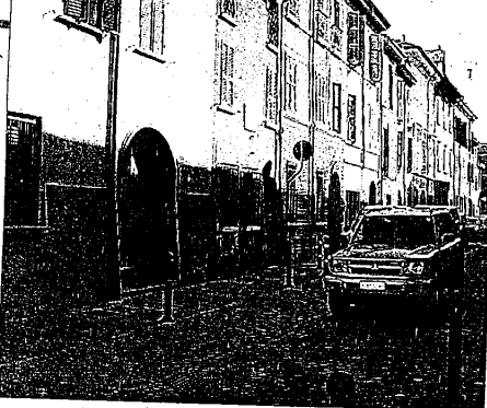
Dopo quasi quattro mesi di lavori e qualche intoppo tecnico di troppo, da domenica la centralissima via Manfredi è di nuovo aperta al traffico. Nuovo il manto stradale, completamente rifatto l'impianto fognario
