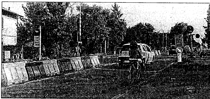
I due passaggi a livello sulla 'provinciale' Felisio destinati ad essere eliminati
