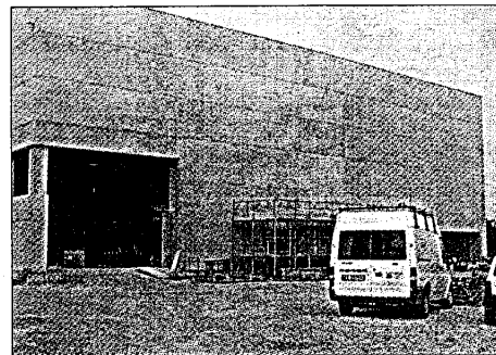
Il nuovo Palasport in costruzione in viale Europa
