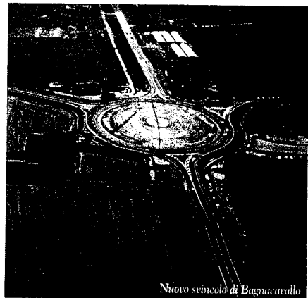
Nuovo svincolo di Bagnacavallo
