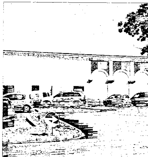
Parcheggi pronti, ma la grana-agibilità rischia di far slittare la data di apertura del Globo-2
