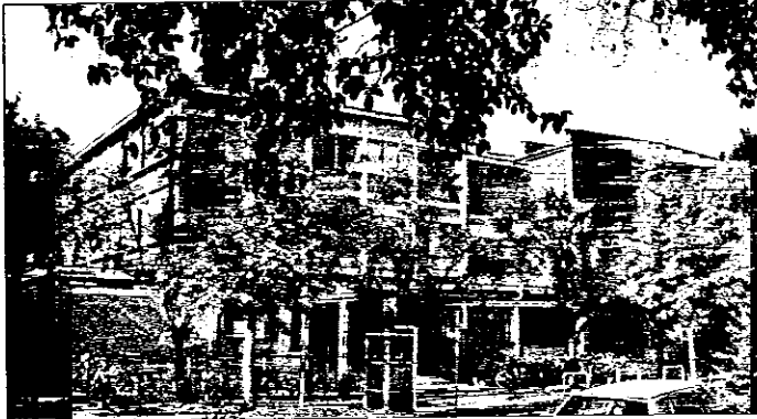
Interventi di bonifica e restauro degli elementi in calcestruzzo e della copertura dell'aula magna. Quali saranno, quindi gli interventi?
