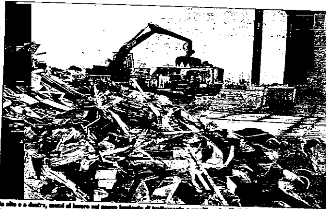
In alto e a destra, lavori al nuovo impianto di trattamento e smaltimento; in basso, sopra il sindaco Raffaele Cortesi (a sinistra) e Brandolini, Tommasi ed altre personalità durante la visita guidata. Foto Massimo Fiorentini
