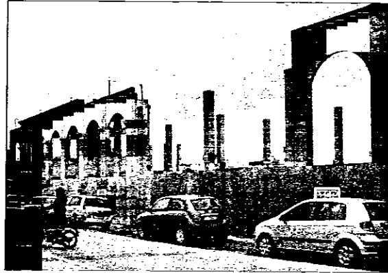
La via Foro Boario all'inizio dei lavori di ampliamento del Globo
