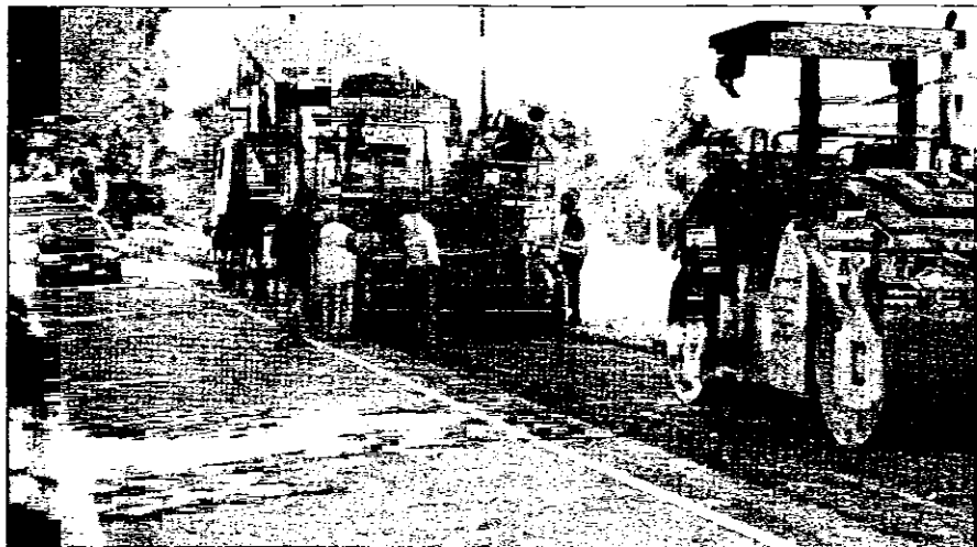
I lavori per la posa del nuovo asfalto sulla ex strada statale San Vitale, nel tratto fra Bagnacavallo e Lugo
