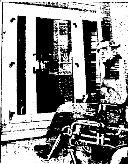
L'edificio di via Emaldi era stato criticato per gli spazi ristretti e per la presenza di barriere architettoniche
