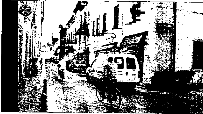
Oltre a Corso Matteotti, l'intervento di ripavimentazione coinvolge anche corso Garibaldi e Largo della Repubblica. In questa strada i lavori sono partiti già da tempo. Foto M. Fioravanti
