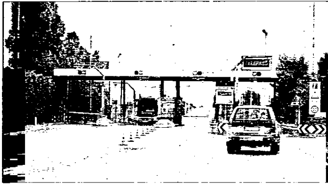
Le rampe d'accesso a Cotignola sono in fase di ultimazione. Foto Massimo Fiorentini
