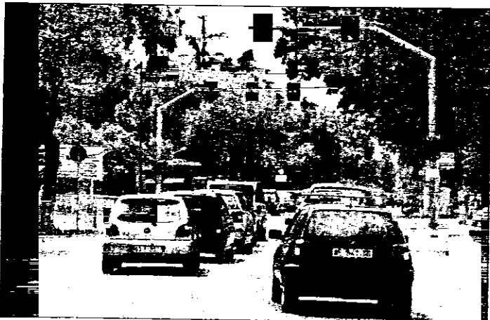
viale Masi, via Acquacalda e corso Matteotti. Un impianto semaforico che, con
