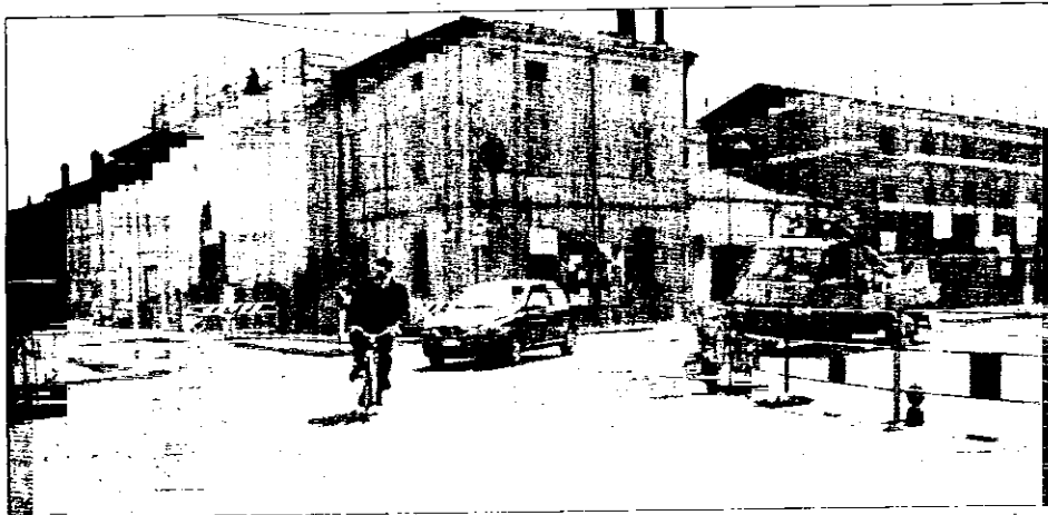
Così si presentava ieri mattina, a conclusione dei lavori, la zona della nuova rotonda di porta Brozzi
