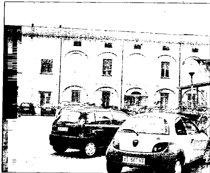
Nel complesso situato tra via Emaldi e via Garibaldi saranno realizzati 21 alloggi destinati agli anziani. La spesa sarà di due milioni e 300mila euro
