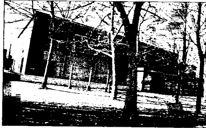
Il palazzetto di via Tamogni dove attualmente sono in corso alcuni lavori di rifacimento della recinzione (foto Bertoldi)
