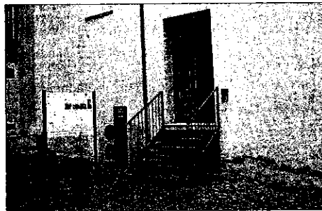
I pannelli posizionati alla Rocca di Lugo
