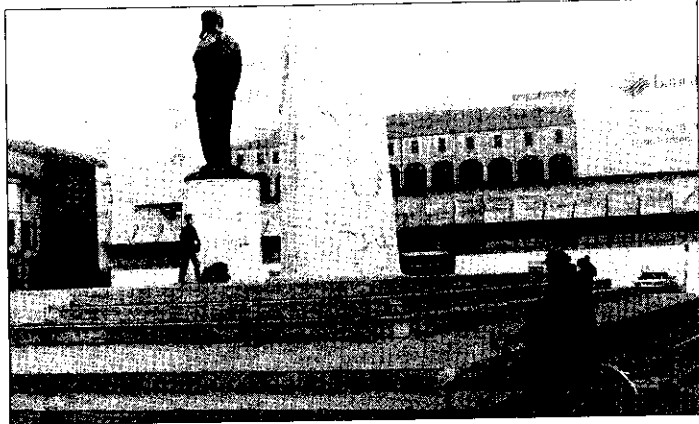
Sullo sfondo, il cantiere della Banca di Romagna prospiciente piazza Baracca
