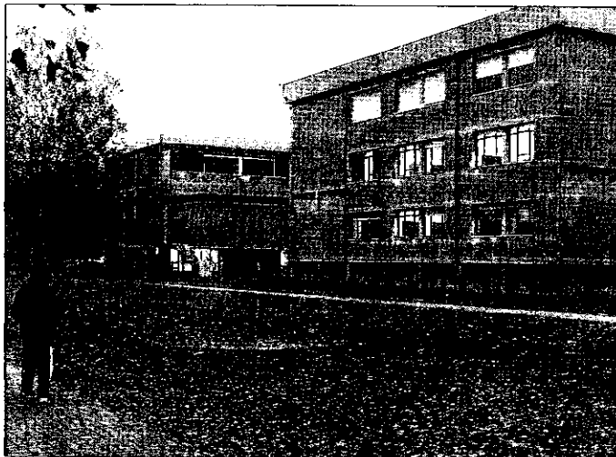
Il liceo scientifico. Nel 2003 inizieranno i lavori di ampliamento della scuola
