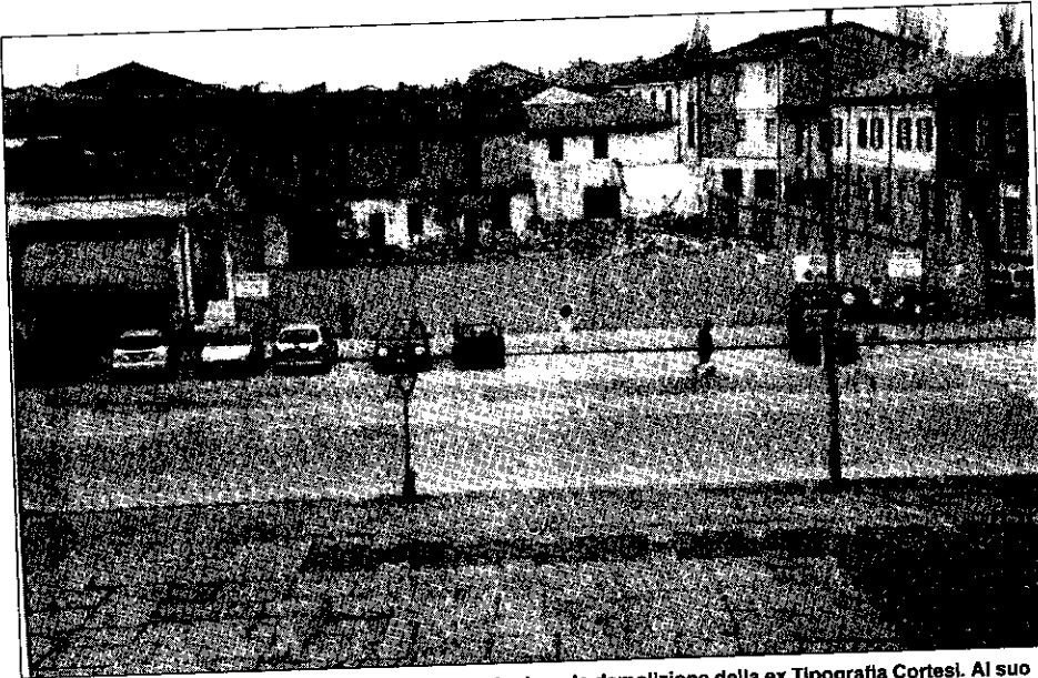
Così appare la zona tra via Mariotti e piazza 1° Maggio dopo la demolizione della ex Tipografia Cortesi. Al suo posto sorgerà un edificio di tre piani, con negozi e uffici a piano terra e appartamenti nei piani superiori
