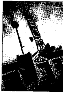
L'installazione di un'antenna per la telefonia mobile ha causato le proteste di diversi cittadini
