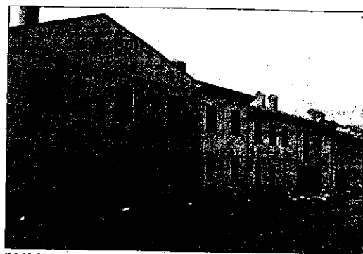
Il fabbricato di proprietà del Comune, appena ristrutturato
