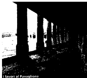
I lavori al Pavaglione
