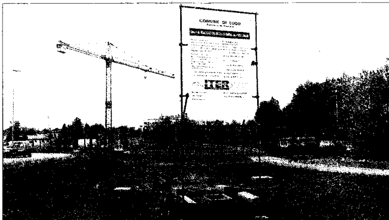
Il cantiere della nuova sede della Polizia municipale in via Provinciale Cotignola. Sullo sfondo l'ospedale.
