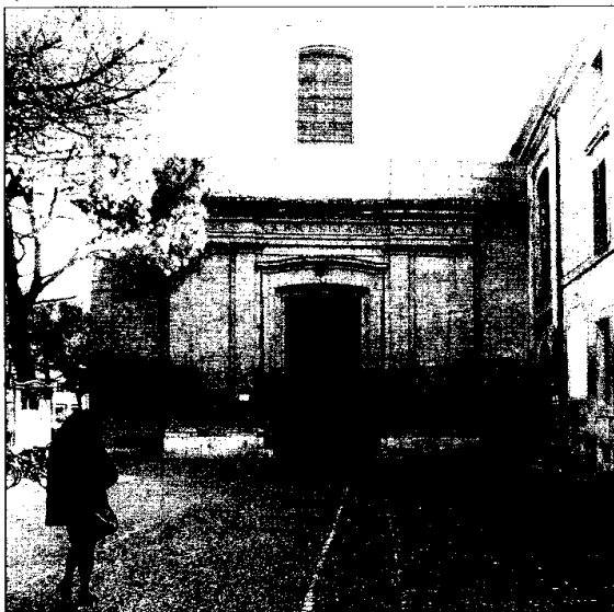
Il complesso del Carmine necessita di interventi non solo per il chiostro e la chiesa, ma anche per l'acciottolato esterno gravemente degradato.
