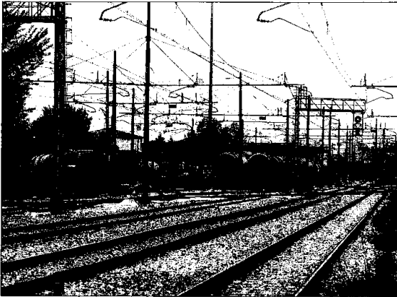
Lo scalo merci di Lugo sarà spostato nell'area del Centro intermodale appena sarà pronto il terminal ferroviario attualmente in costruzione. (Foto Zani)
