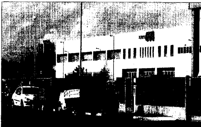
Uno dei primi insediamenti nel Centro merci intermodale di Lugo è stato quello della Nealco Sidis, centro di distribuzione per i punti vendita del Crai.
