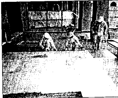
Da mesi ormai nel centro storico sono al lavoro vari cantieri
