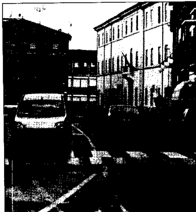
Uno scorcio di piazza Trisi attualmente al centro di lavori di manutenzione. (Foto Giampiero Corelli)
