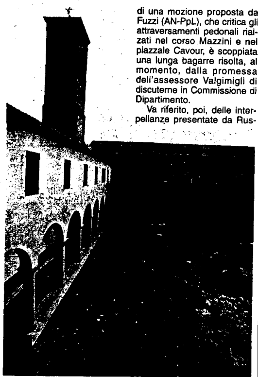
L'ex Convento di San Domenico durante i lavori di restauro
