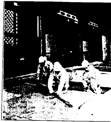
Operai al lavoro lo scorso anno per sistemare la pavimentazione del lato sud del Pavaglione.
