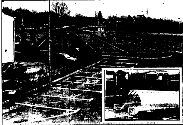
Dopo una lunga diatriba sembrano finalmente risolti i problemi delle infiltrazioni nel sottopassaggio (nel riquadro) del nuovo parcheggio dell'ospedale di Lugo. I 500 posti auto saranno disponibili dal 27 giugno. (Foto Giampiero Corelli)
