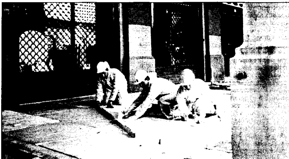
Tecnici al lavoro al Pavaglione sulle lastre della pavimentazione.
