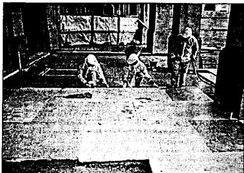
Un momento dei lavori di pavimentazione del Pavaglione
