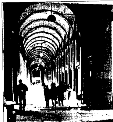
I lavori di restauro della pavimentazione del Pavaglione comporteranno una spesa di 500 milioni.
