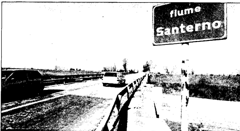
Il ponte sul fiume Santerno al centro dei lavori che da ieri hanno portato alla chiusura della statale 'Adriatica' nei pressi di Voltana. (Foto Fabrizio Zani)
